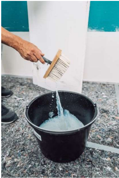
Verdünnte Silikatgrundierung auf allen Seiten aufstreichen
