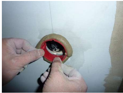
Putzausgleichsring mit Kleber einbetten
