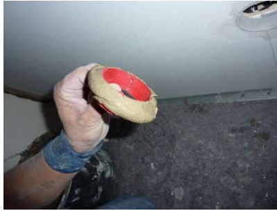
Putzausgleichsring mit Kleber einbetten
